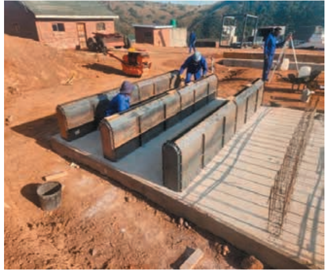
I-Tank Slab Plinths iyaqhubeka.
