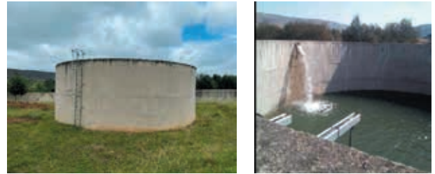
Itanki elidala eligcina amanzi angacocwanga. Ukungangeneleli kwamanzi kuzakwenziwa ngunokhontilakhi oncedisayo oyingcali.
