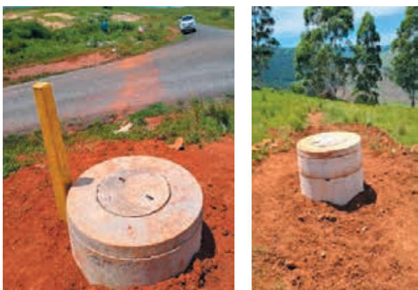
Sekuqediwe ukufakwa kwamavalvu epayiphini uRM2.
